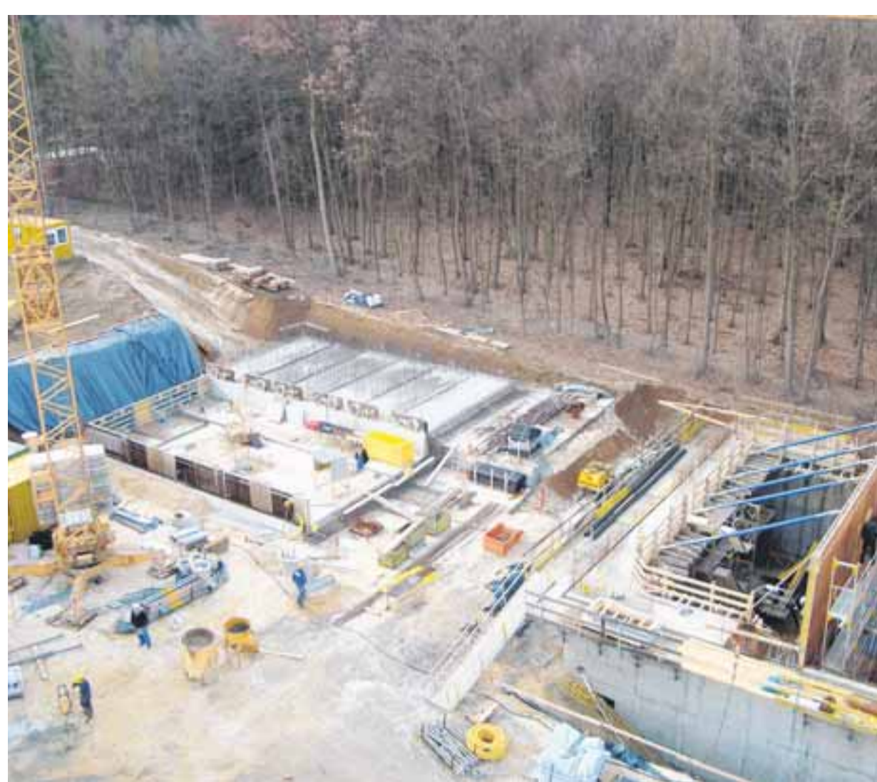
Großbaustelle für weiches Wasser, das 2010 ins Ries fließen soll: Auf dem Sallmannsberg (Gemeinde Blindheim im Landkreis Dillingen) entsteht die Enthärtungsanlage von Rieswasser. Im Sommer soll der Rohbau durch die Nördlinger Bauunternehmung Carl Heuchel fertiggestellt sein.
