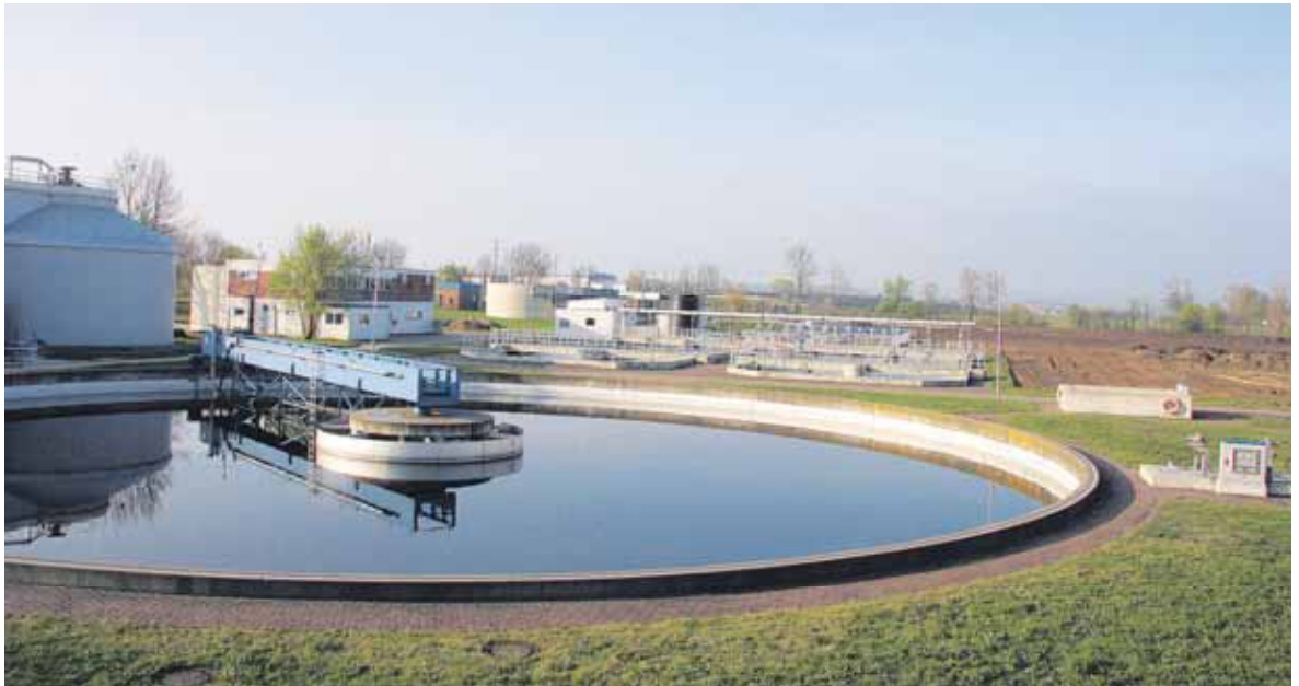
Die Nördlinger Kläranlage wird grundlegend modernisiert und erweitert. Es ist der größte Auftrag in der Geschichte des Nördlinger Bauunternehmens Heuchel. Foto: dima
